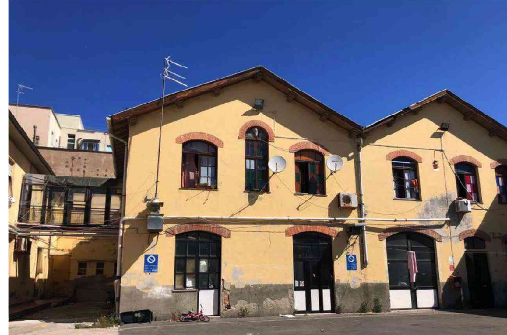
I DUE CAPANNONI DEPOSITO
